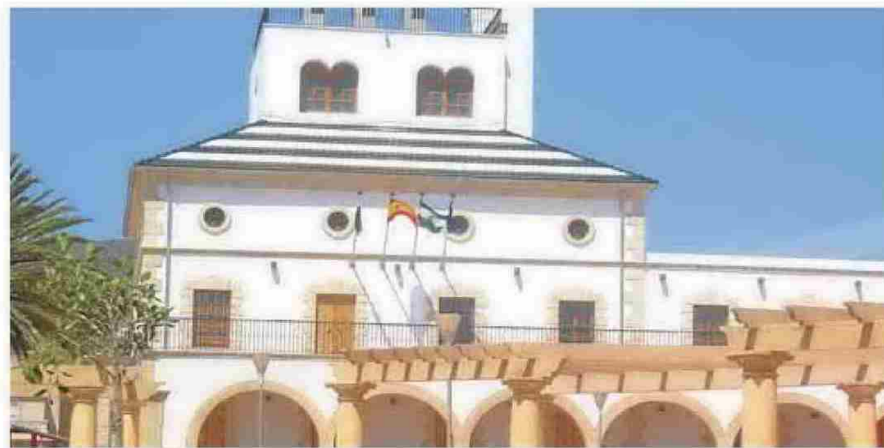
FACHADA del Ayuntamiento de Huércal de Almería.
