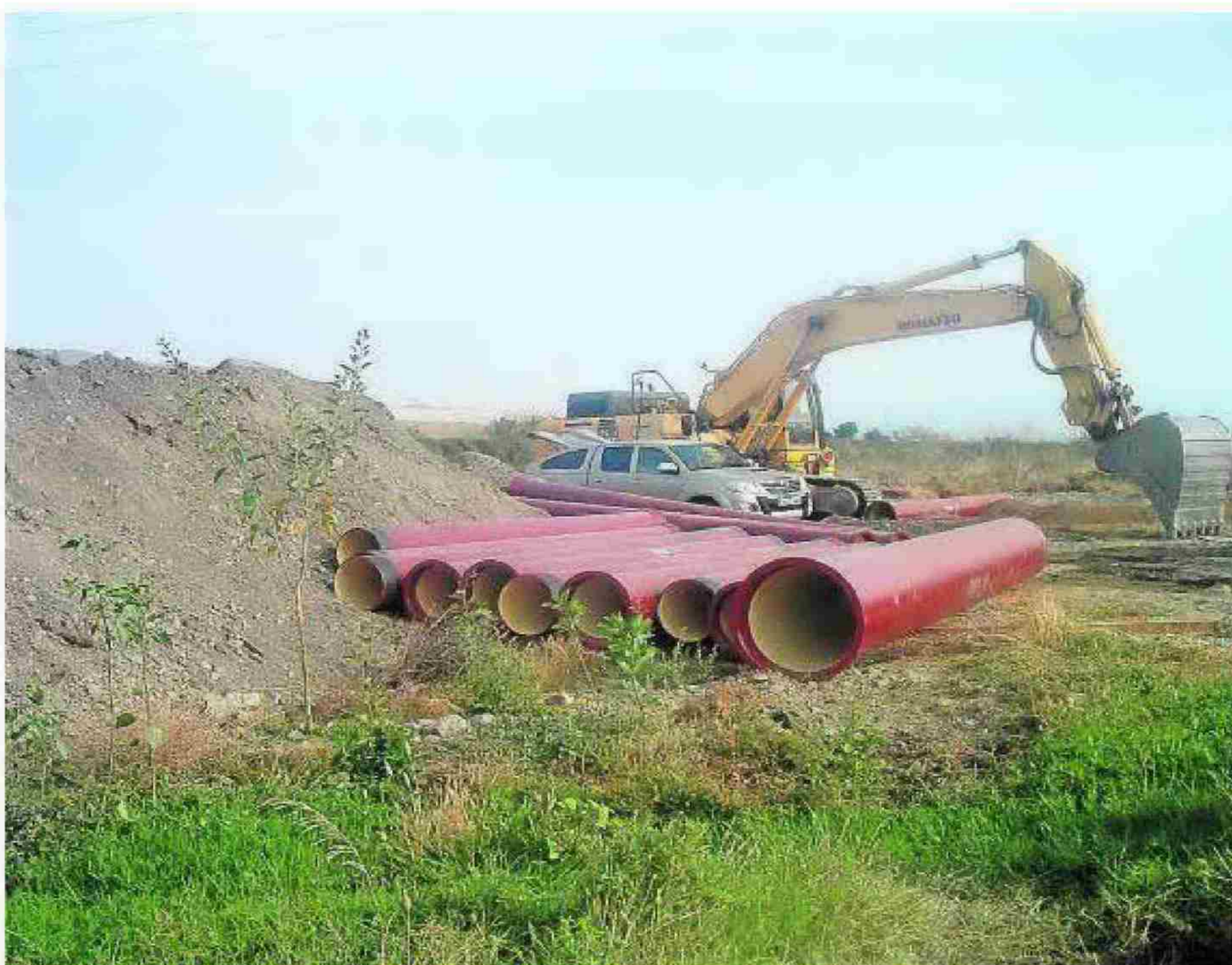
Material que está siendo empleado en las obras de mejora de las redes. :: IDEAL
