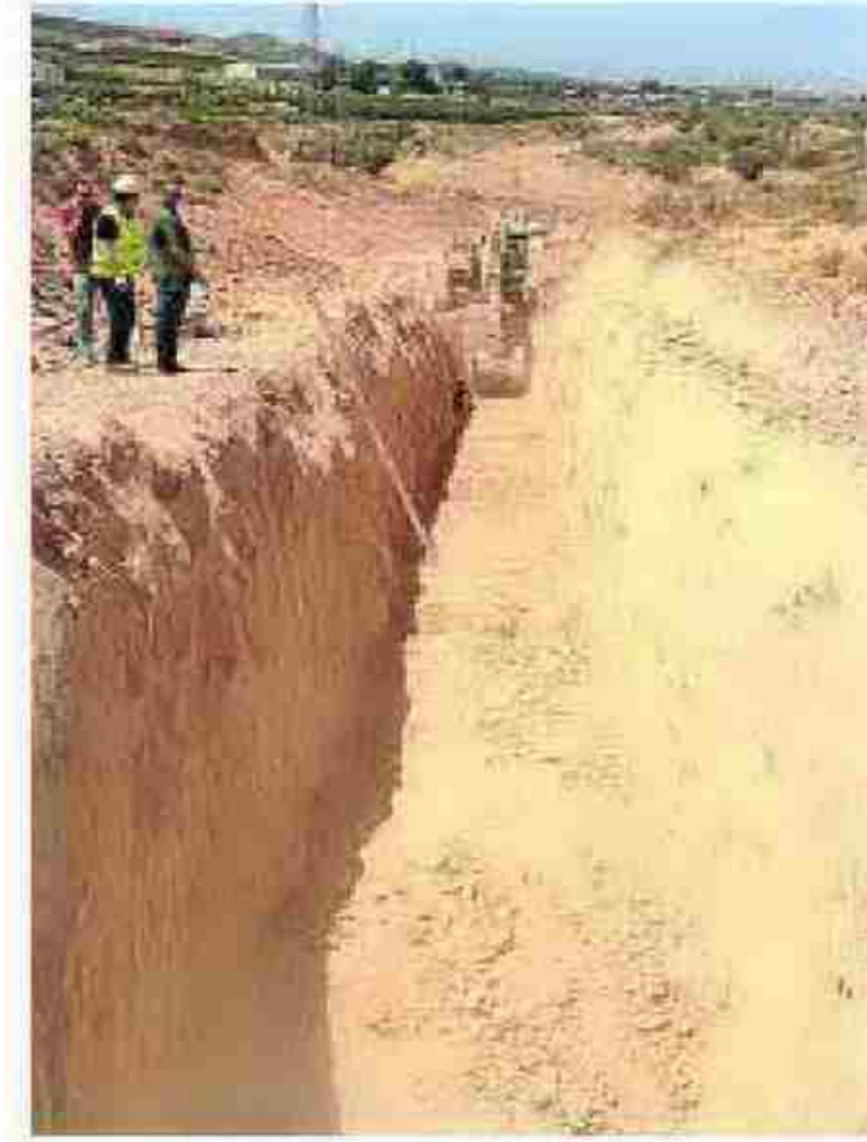
Excavación de una zanja. :: IDEAL
