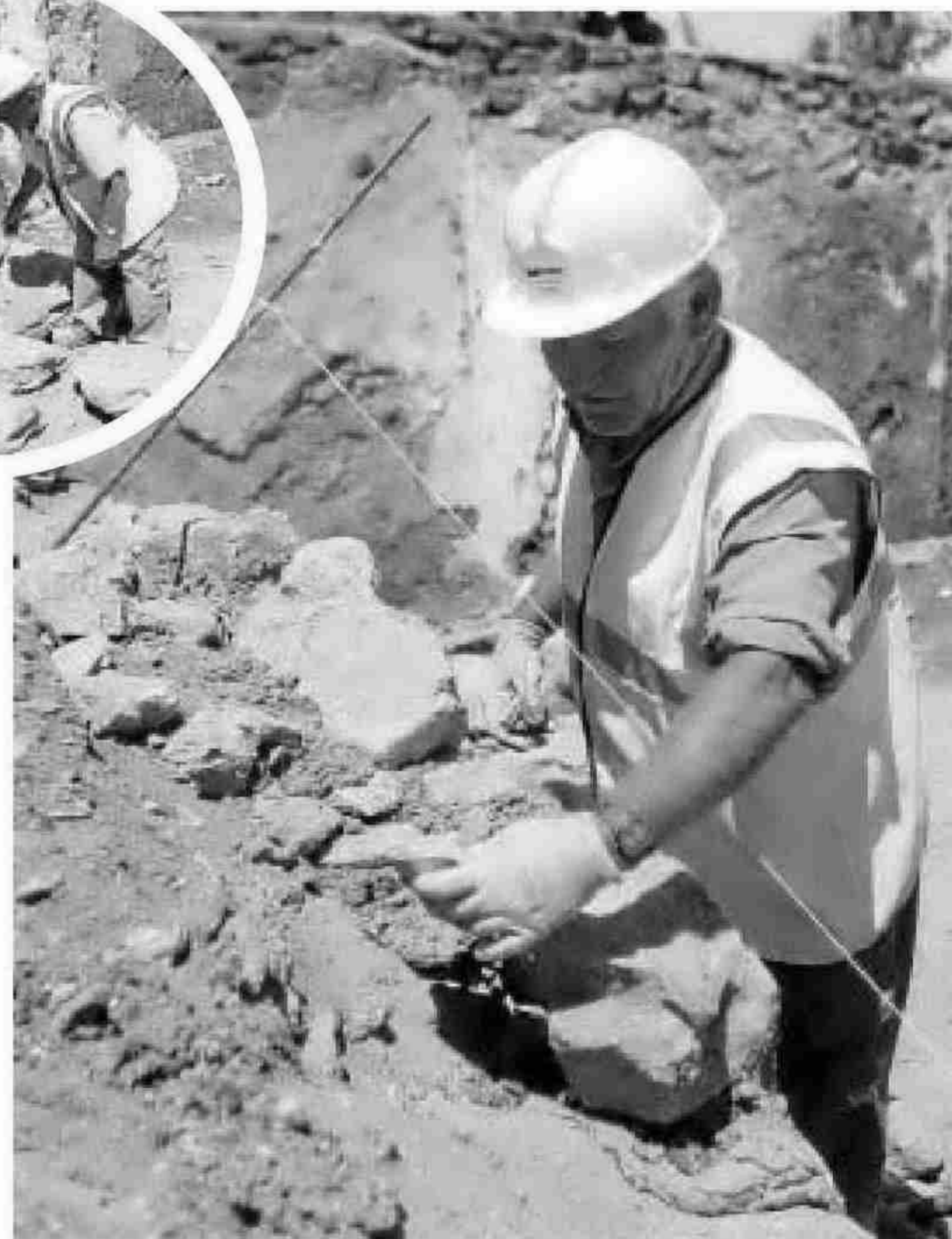
Manuel Berrezo trabaja en la construcción de un muro en la Arquilla.
