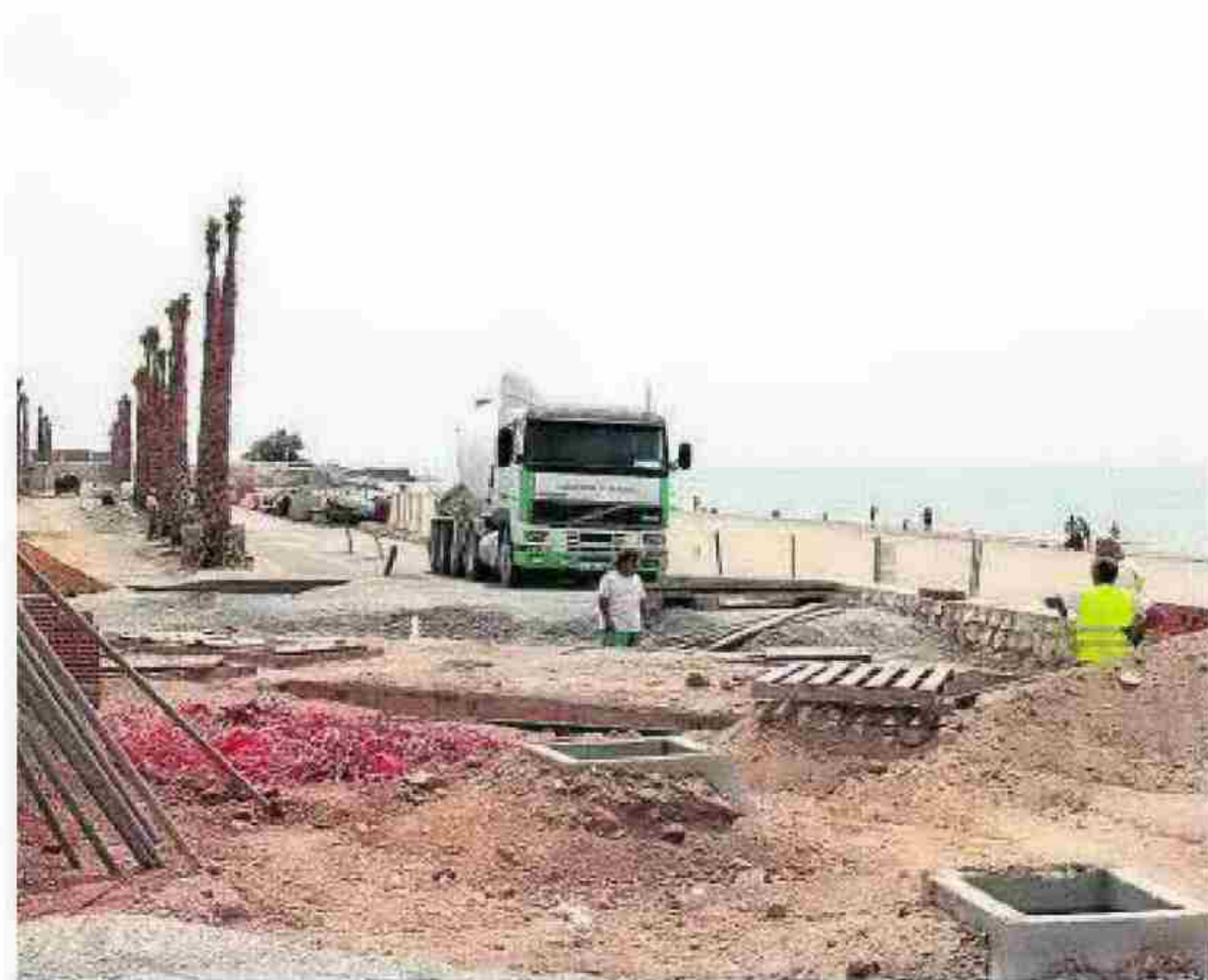
Operarios durante los trabajos de ampliación. :: c. l.
