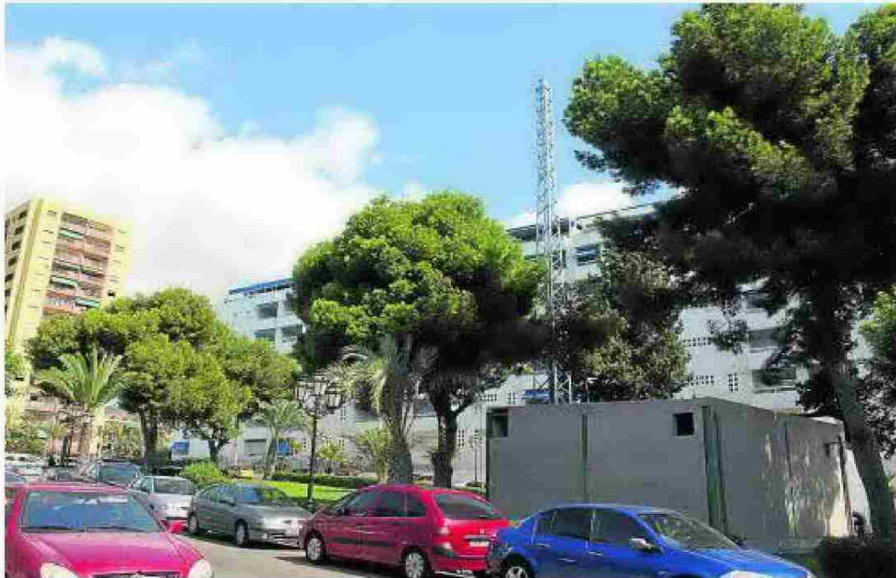
La chimenea se encuentra a poco más de 20 metros del edificio. :: VALDIVIA
