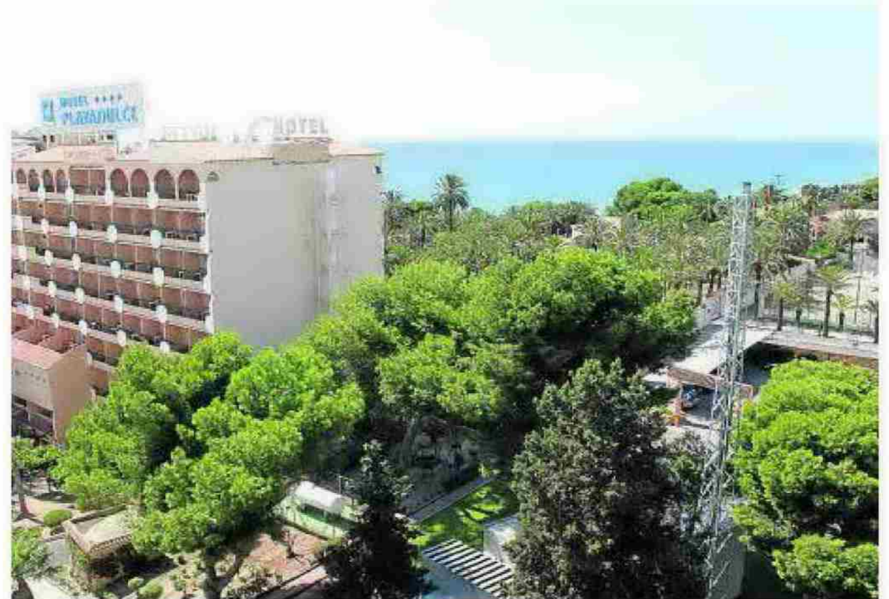
Aspecto que presenta la chimenea junto al hotel Playadulce. :: VALDIVIA
