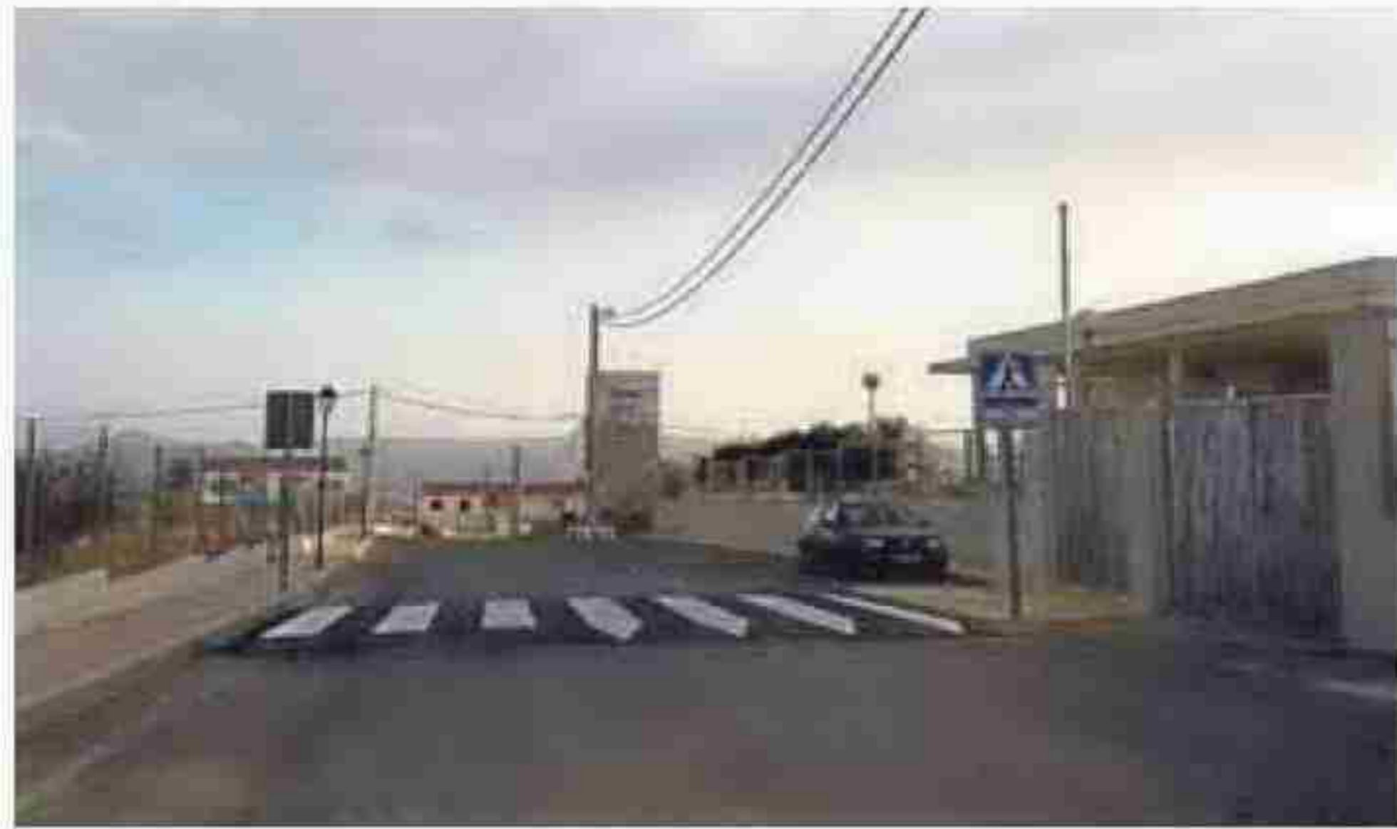
RESALTO instalado en la pedanía de Úrcal. LA VOZ
