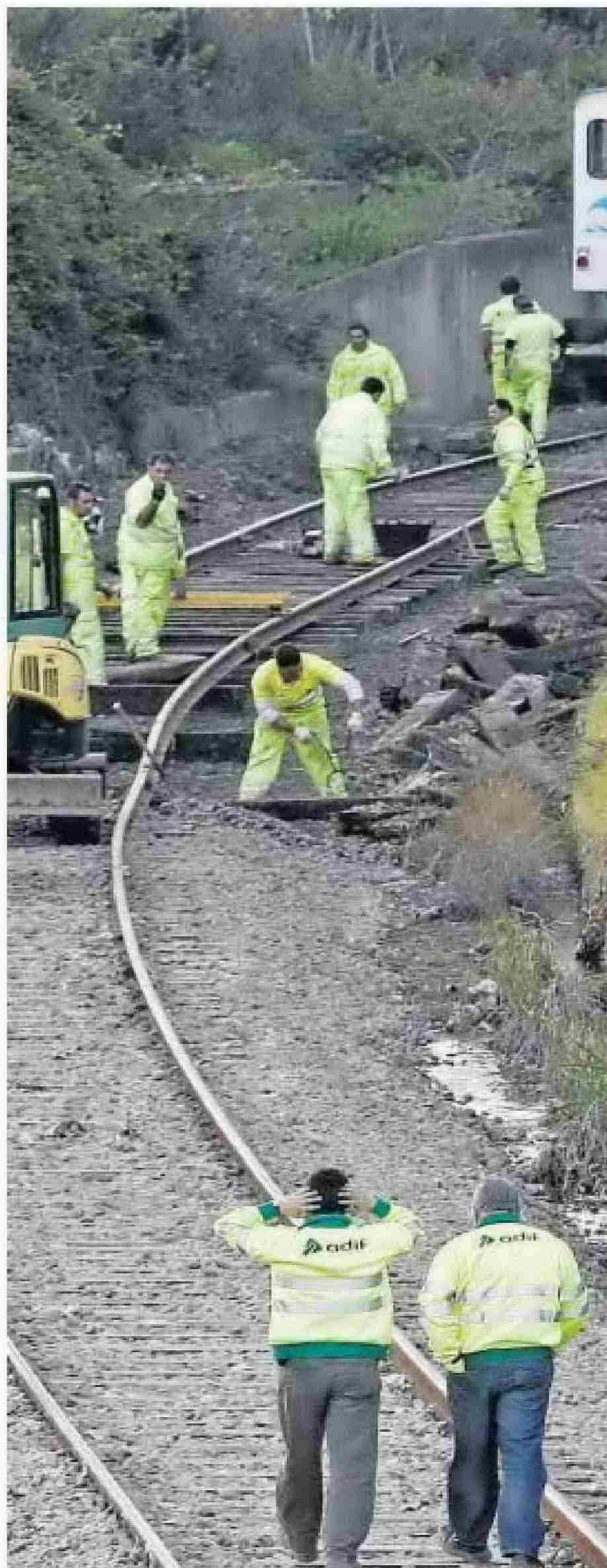
Operarios trabajando en el ramal de mercancías de la Algeciras-Bobadilla.
