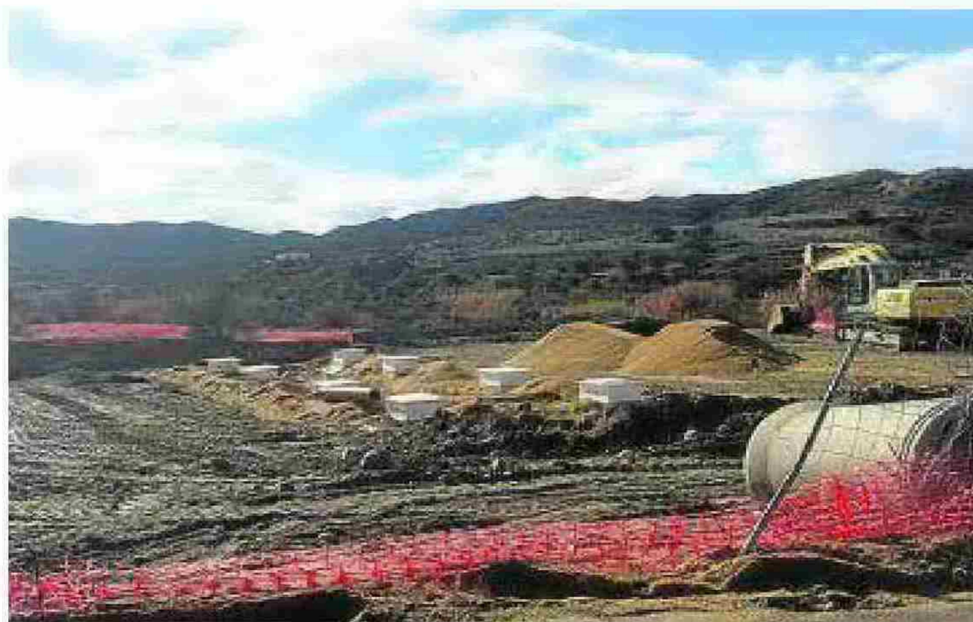
Inicio de las obras en La Edar de los Torres de Arboleas. :: E. BENÍTEZ
