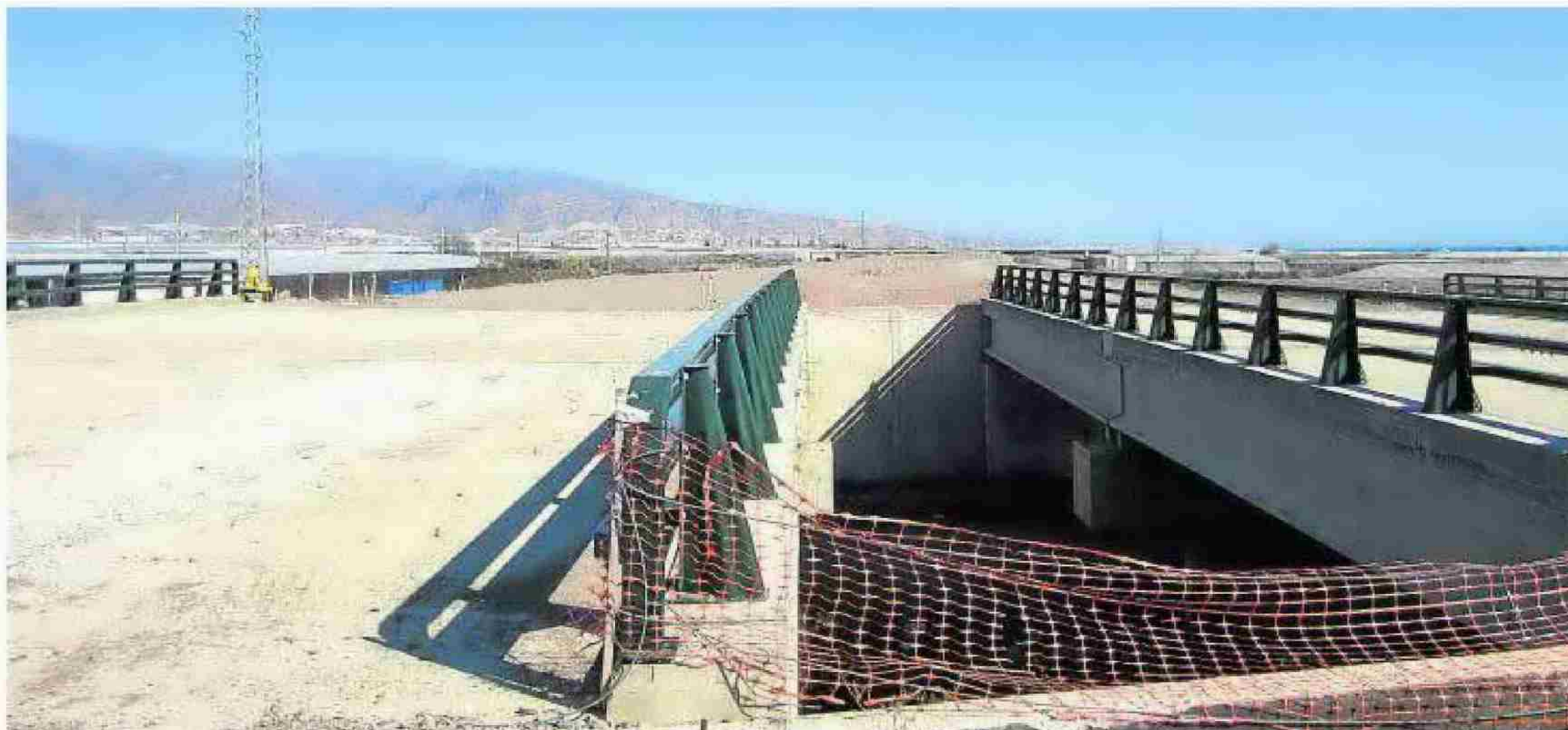
Las obras llevan paradas cuatro años. :: VALDIVIA
