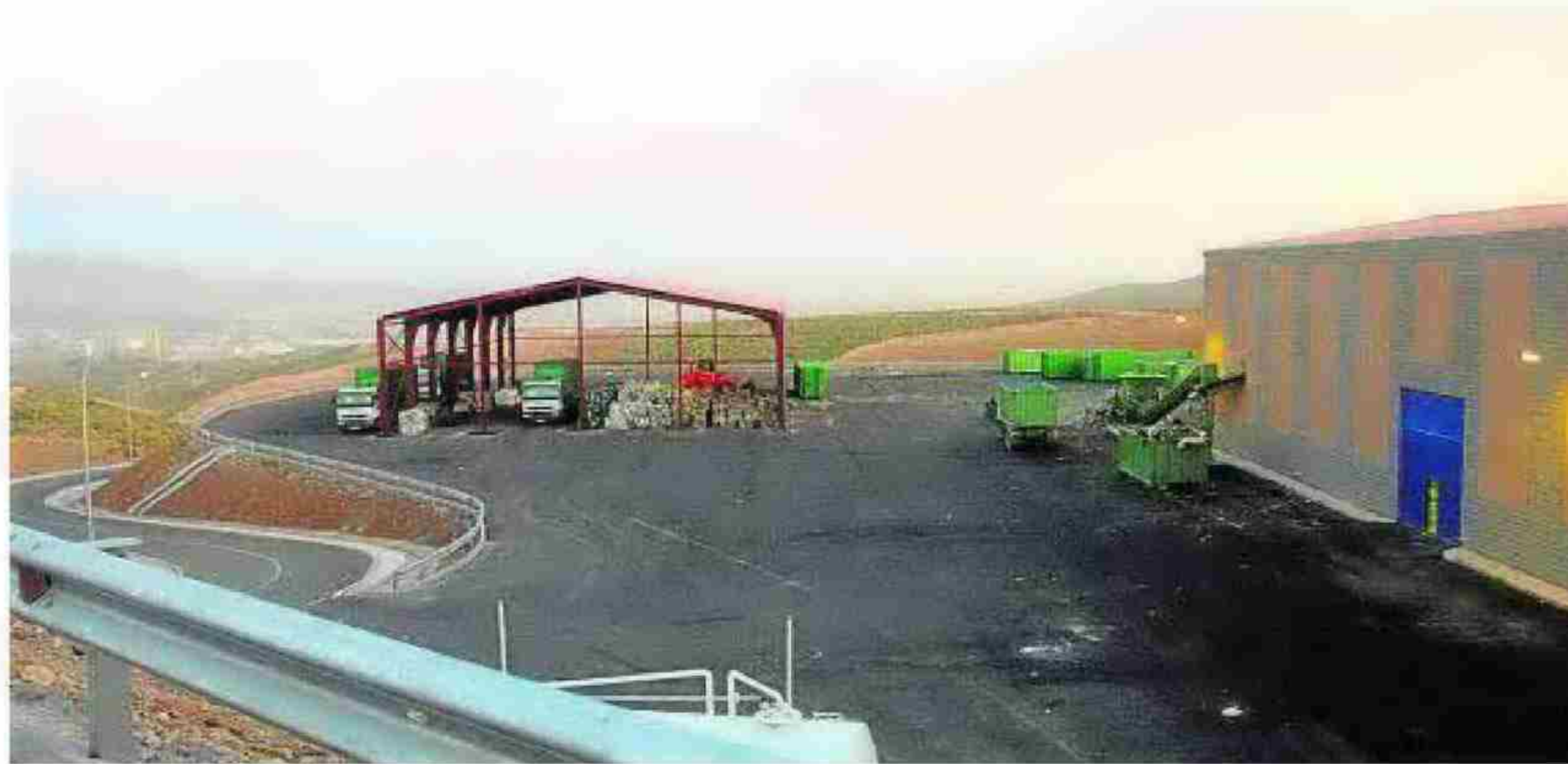
Imagen de la planta de residuos del Consorcio del Poniente, en Gádor. :: IDEAL
