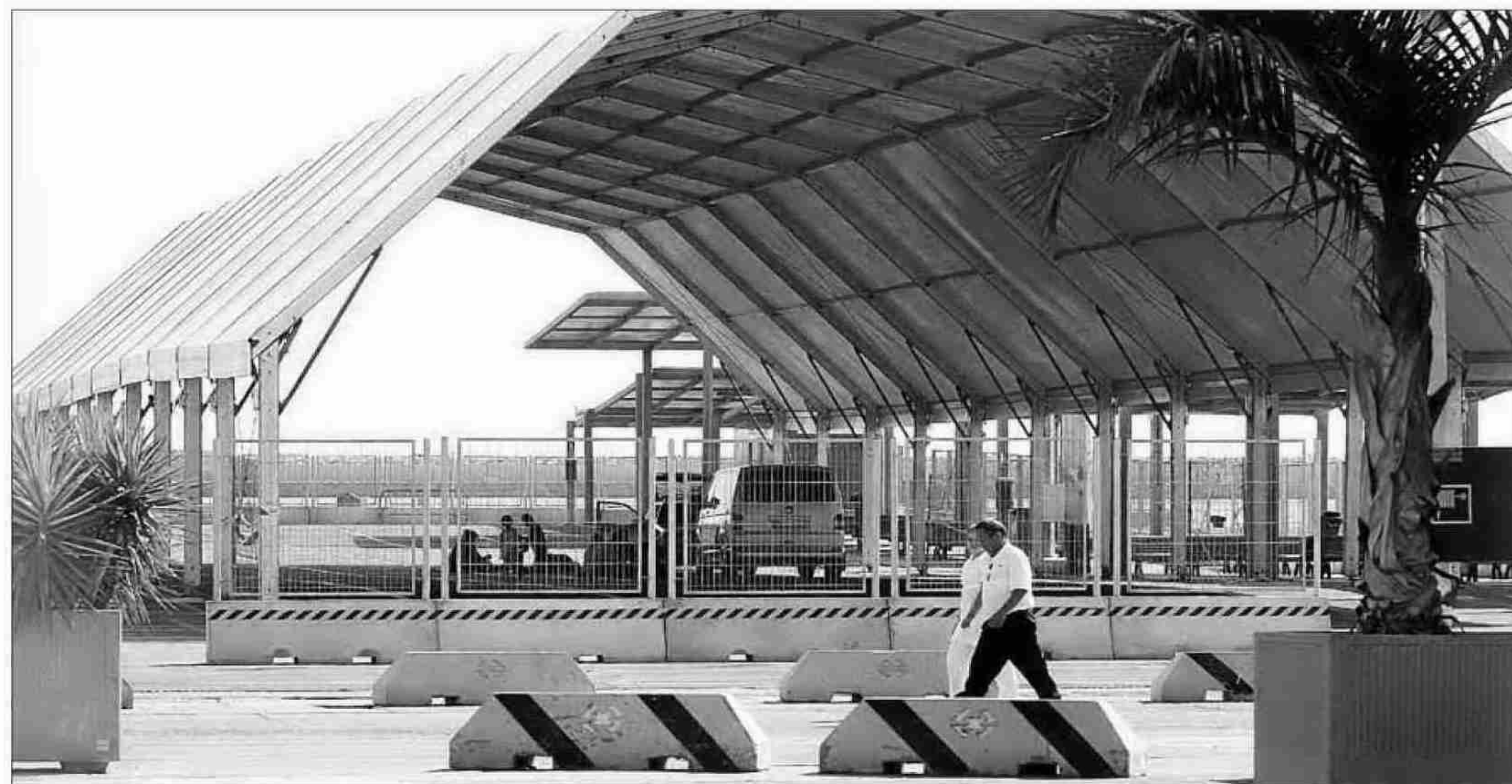
■ Panorámica del Puerto de Almería ayer, con escasa actividad. / JUAN SÁNCHEZ
