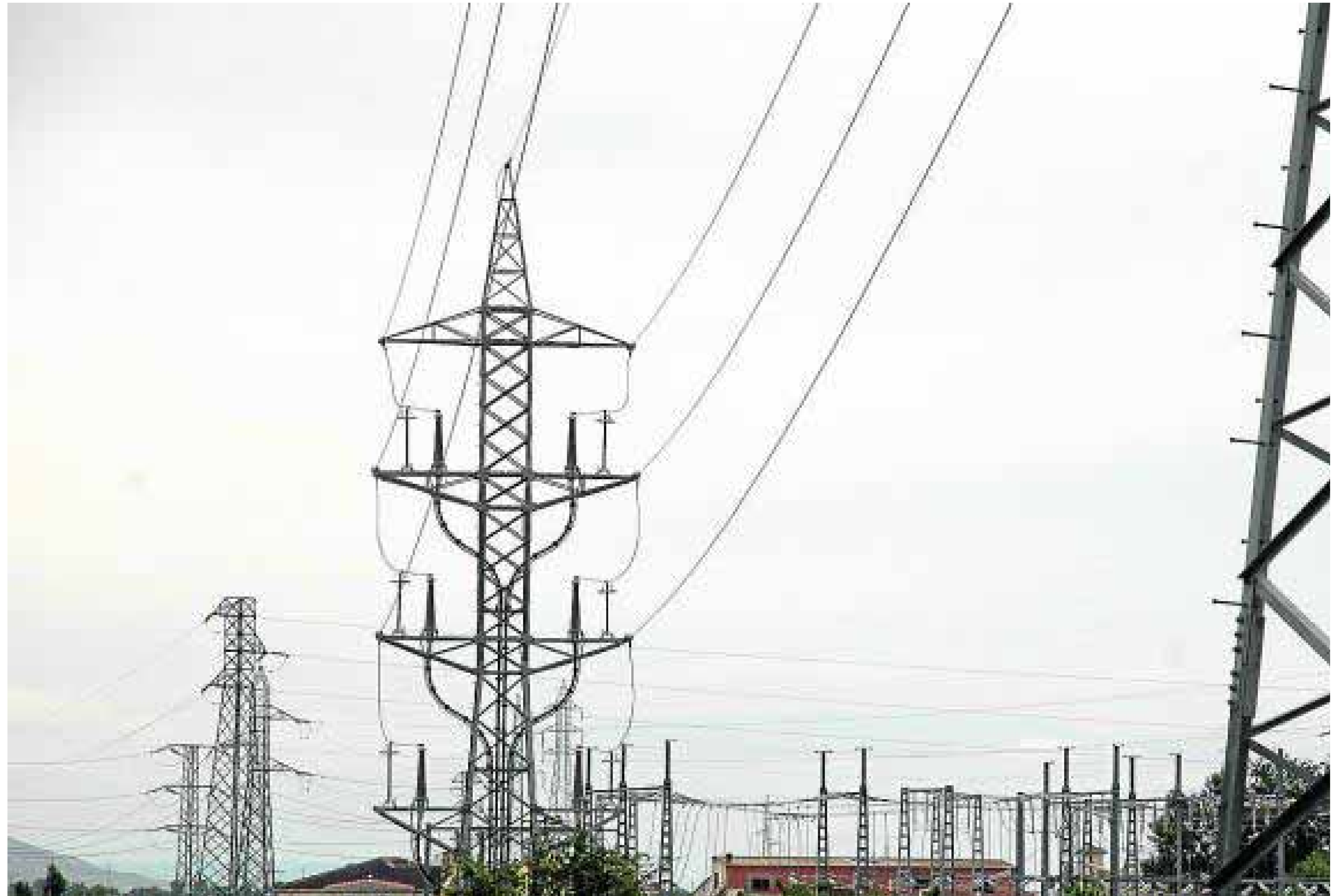
Tendidos eléctricos próximos al municipio de Serón. :: IDEAL
