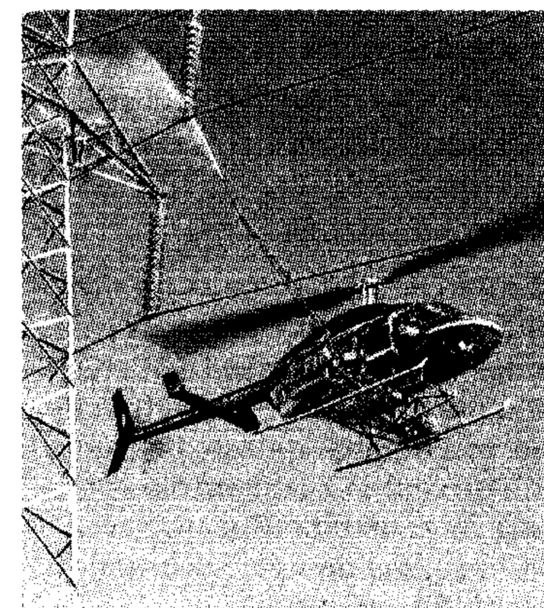
Limpieza de líneas eléctricas. D. A.
