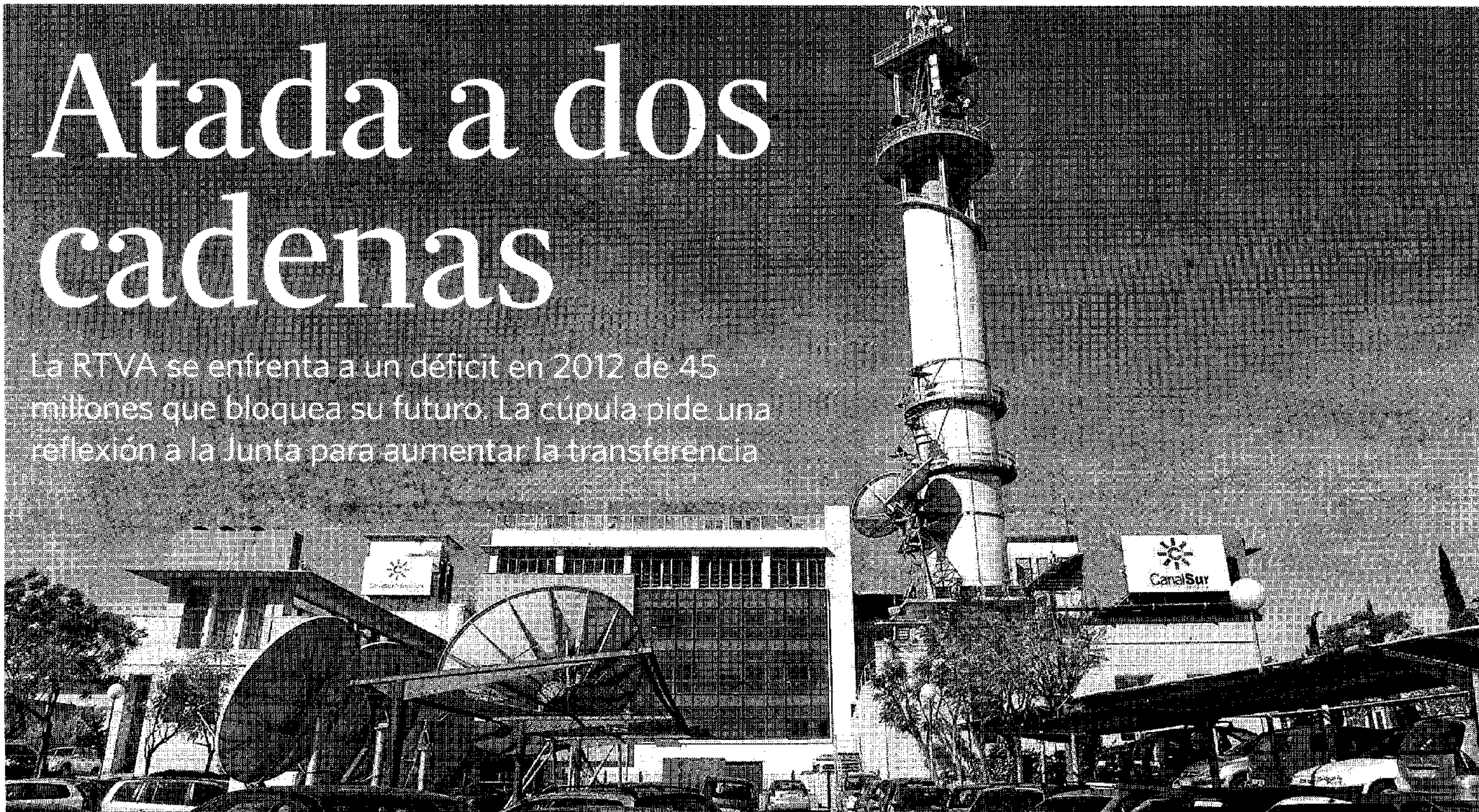
Las instalaciones centrales de la RTVA, en San Juan de Aznalfarache.
