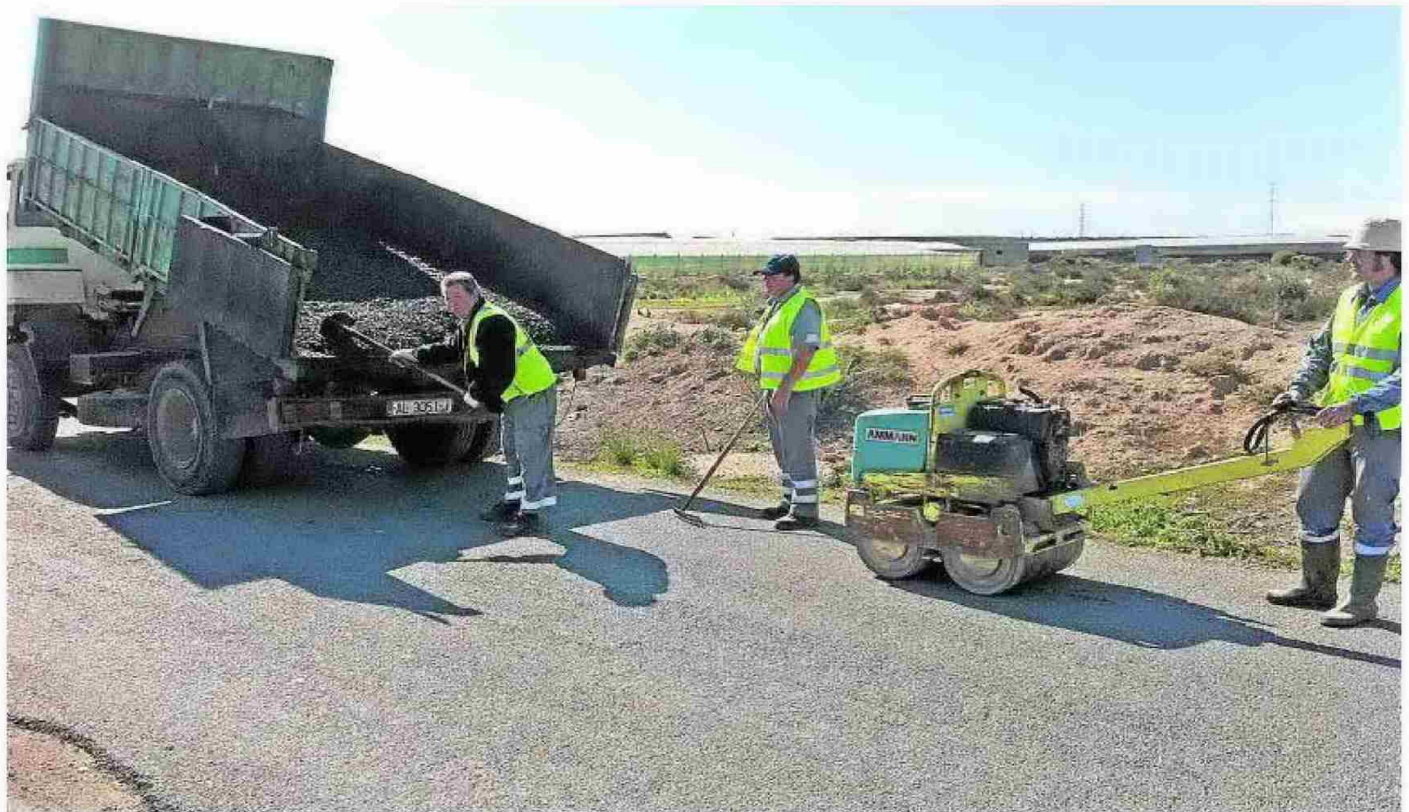
Obreros acondicionan una vía rural de la provincia de Almería. :: IDEAL
